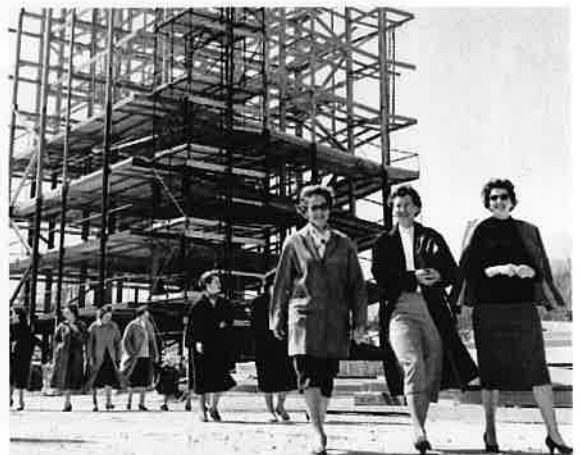
Wohnturm im Bau, 1958. Foto: Philippe Giegel, Schweizerische Verkehrszentrale Zürich (Archiv Familie Hubacher)
